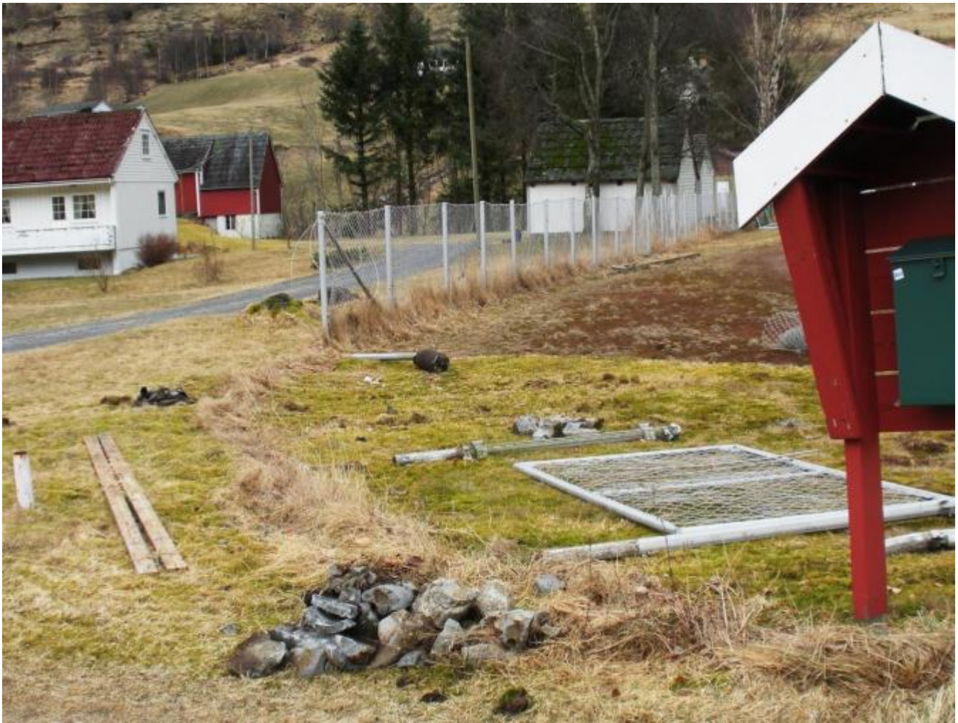
Under reparasjon i dag: Gjerdet rundt Heio!
