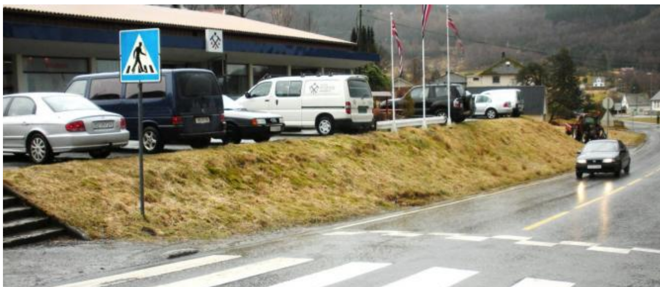
På utsiden av AFA blir det gang- og sykkelveg, med ein vakker mur bak. (Foto: Ola Matti Mathisen)
