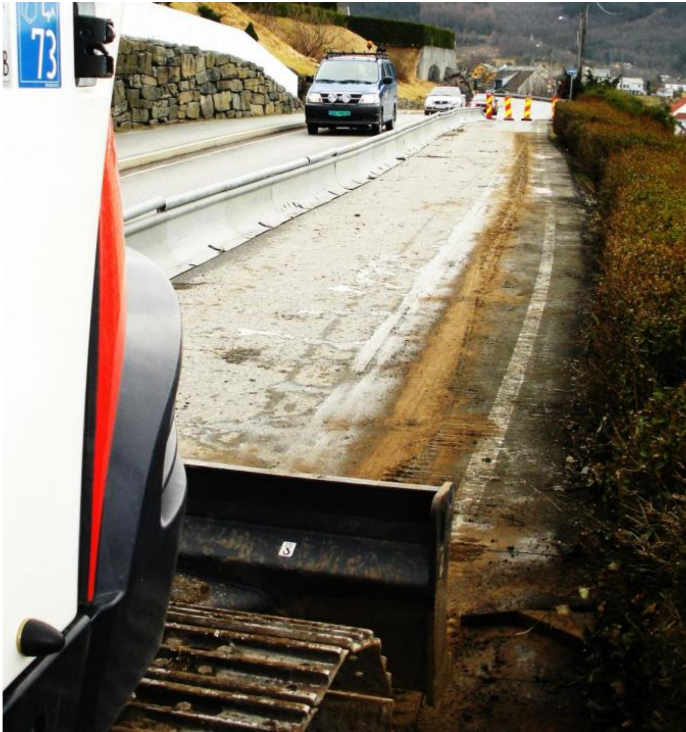
Det skal no monterast stålrekkverk i svingen
