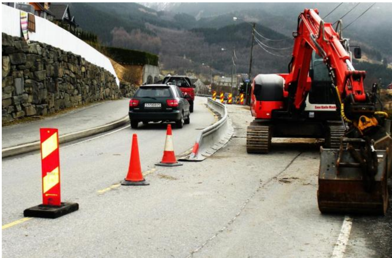
Det er envegskjøring medan arbeidet pågår.
