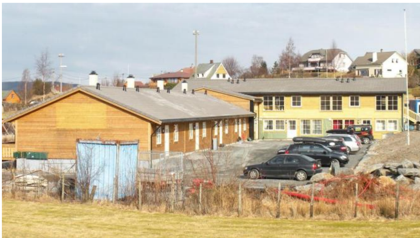
Det er 4 husvære i 2.høgda (lengst inne til høgre) som kan innflyttast no. (Foto: Ola Matti Mathisen)
