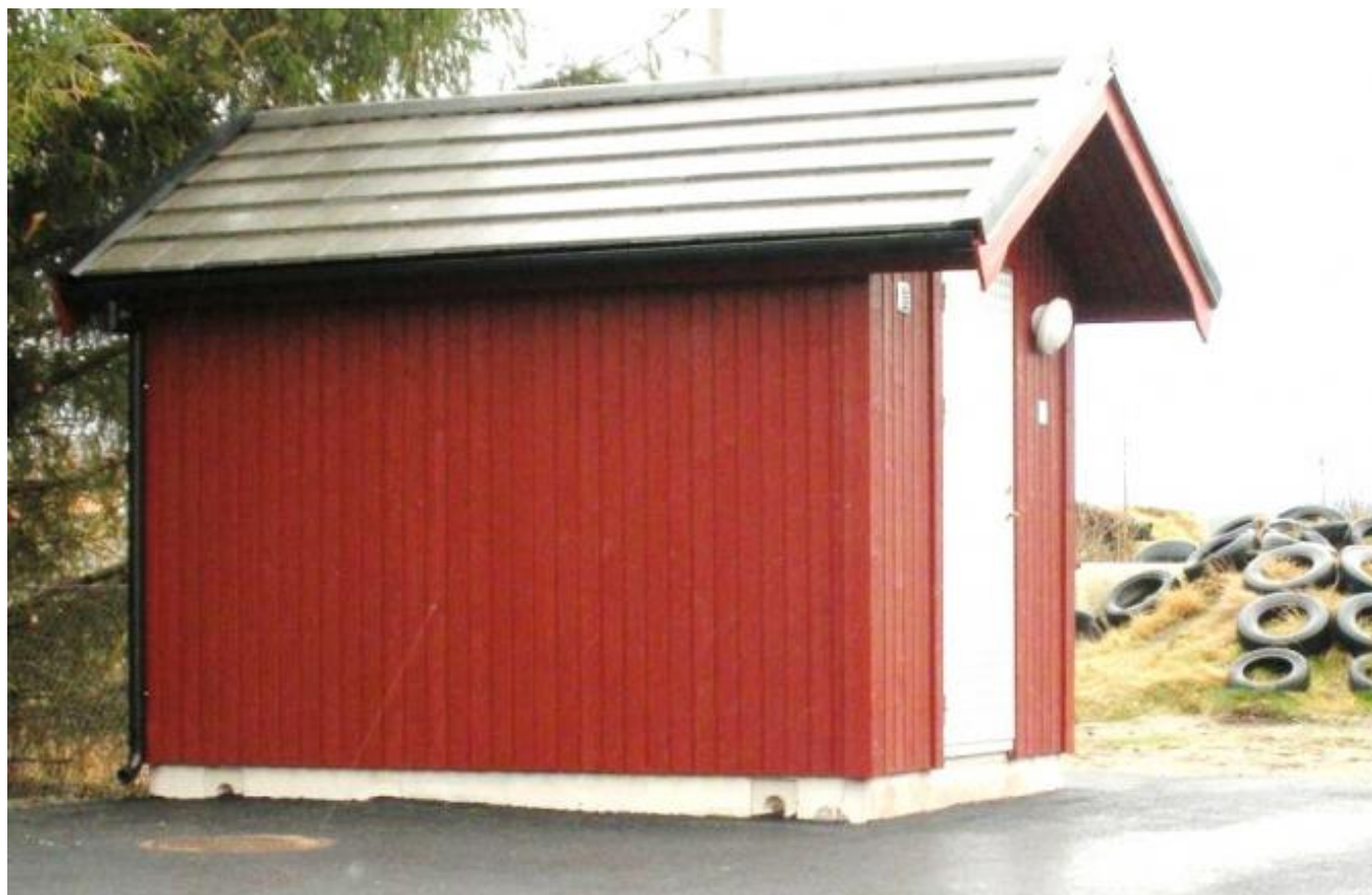
Pumpestasjonen på skuleområdet er i funksjon, men pumpar ikkje kloakk frå båtlag-området førebels (Foto: Ola Matti Mathisen)
