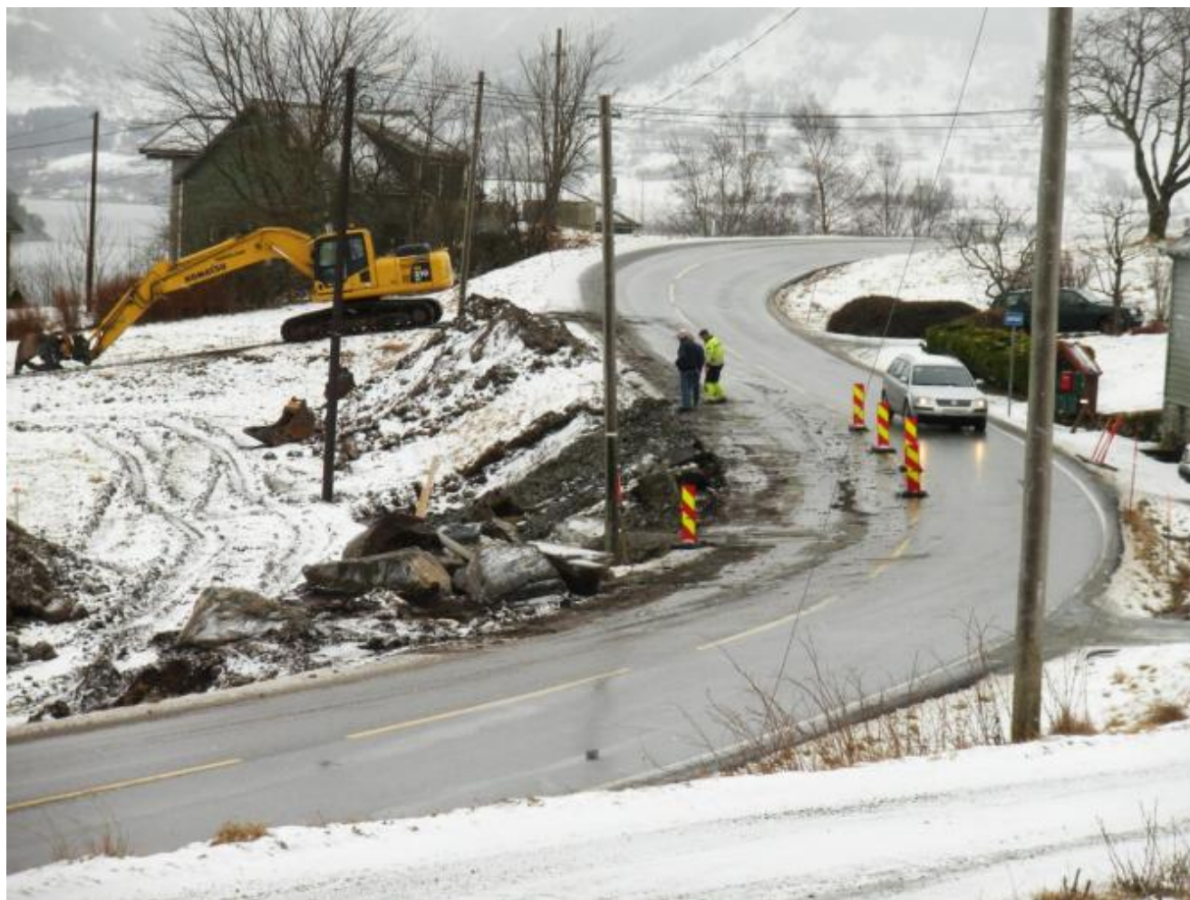
Arbeidet med buss-lomma kom i gang denne veka. Lomma blir på nedsida av vegen medan det blir ein forbetra men enkel stopp på andre sida.
