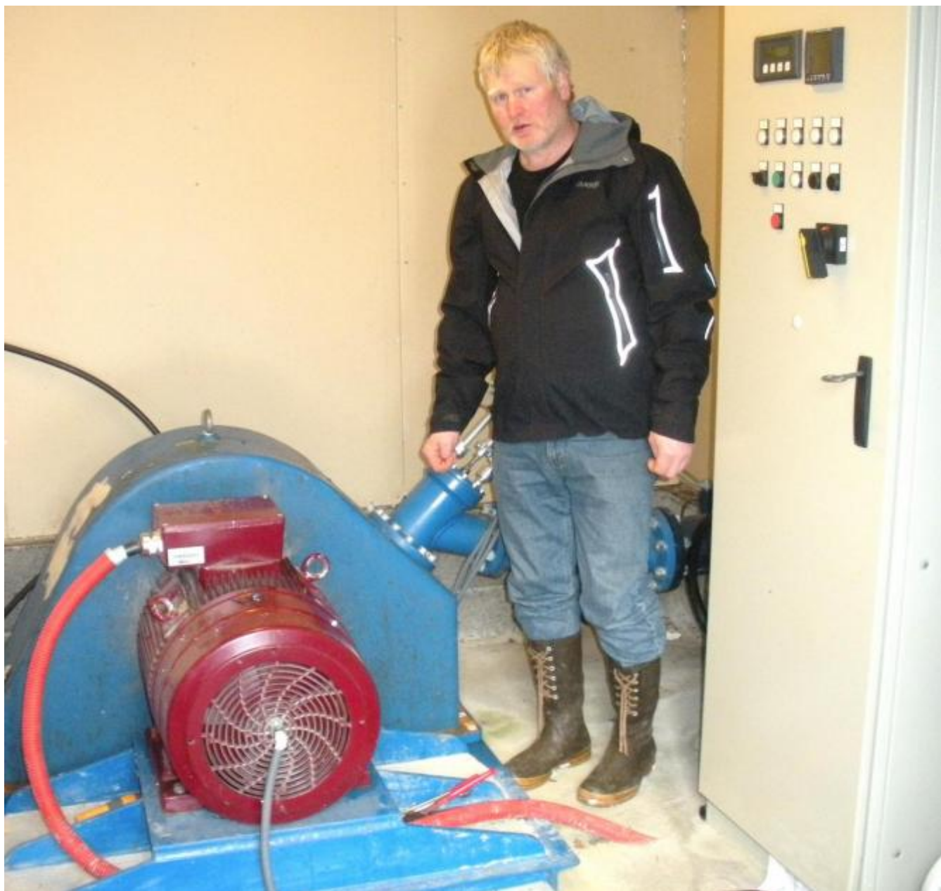
Kurt Eivind Miljeteig står her mellom generator og styringsskap i kraftverket sitt. (Foto: Ola Matti Mathisen)
