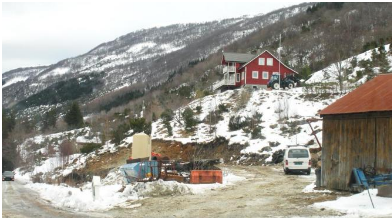
Grunnarbeid er no i gang for driftsbygning (Foto: Ola Matti Mathisen)
