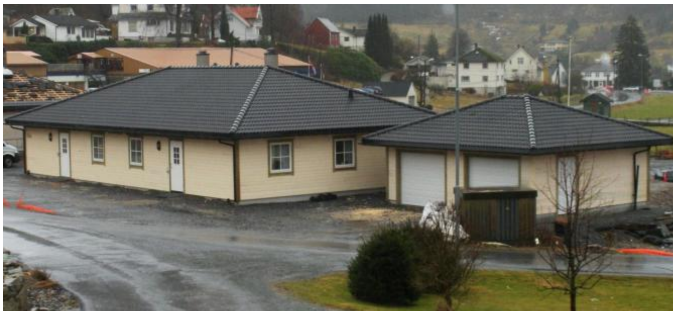
Det er no gjeve bruksløyve for dette huset. (Foto: Ola Matti Mathisen)
