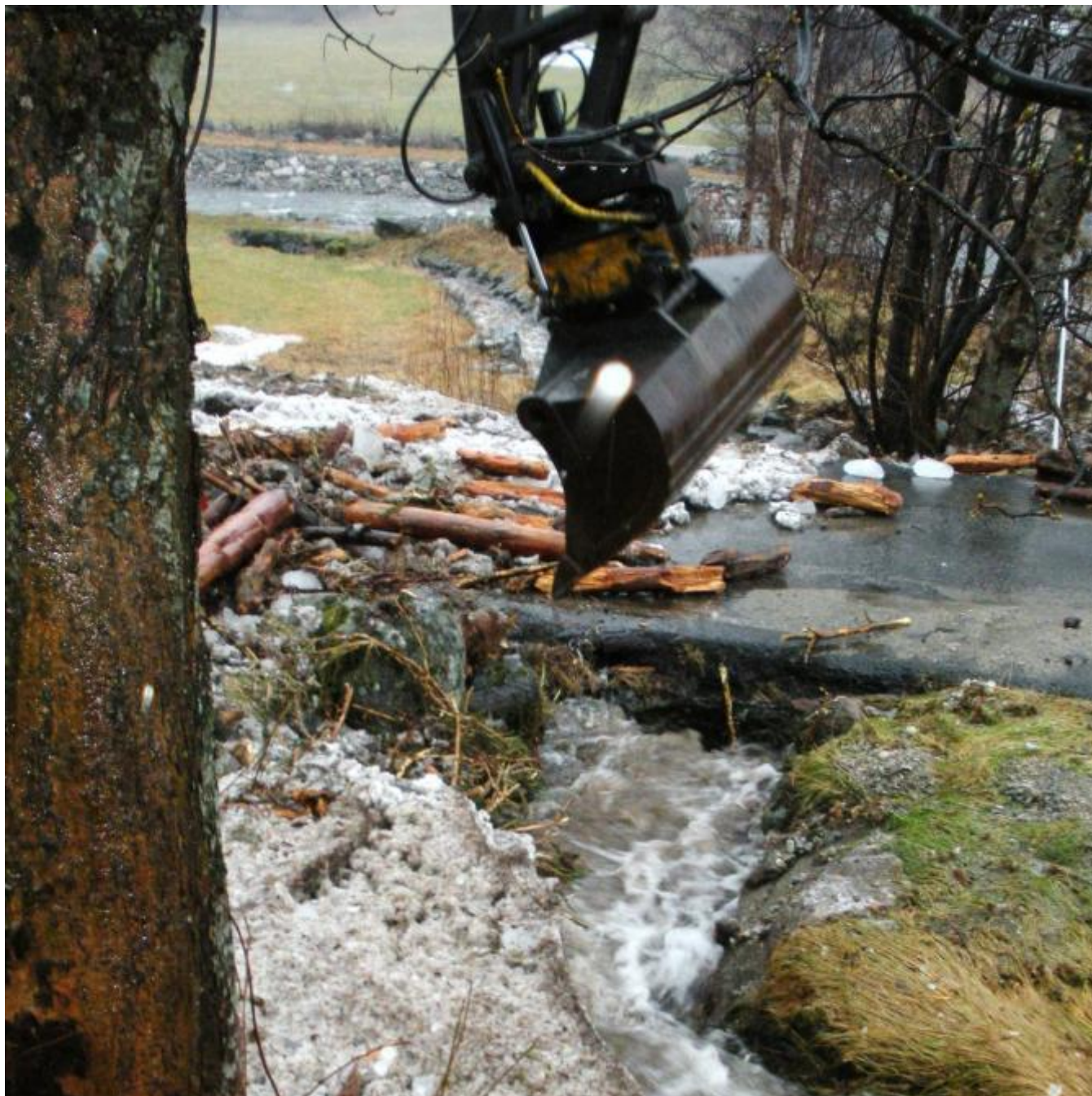
Dimmelsvik Entreprenør har her opna for bekken. I bakgrunnen Uskedalselva.
