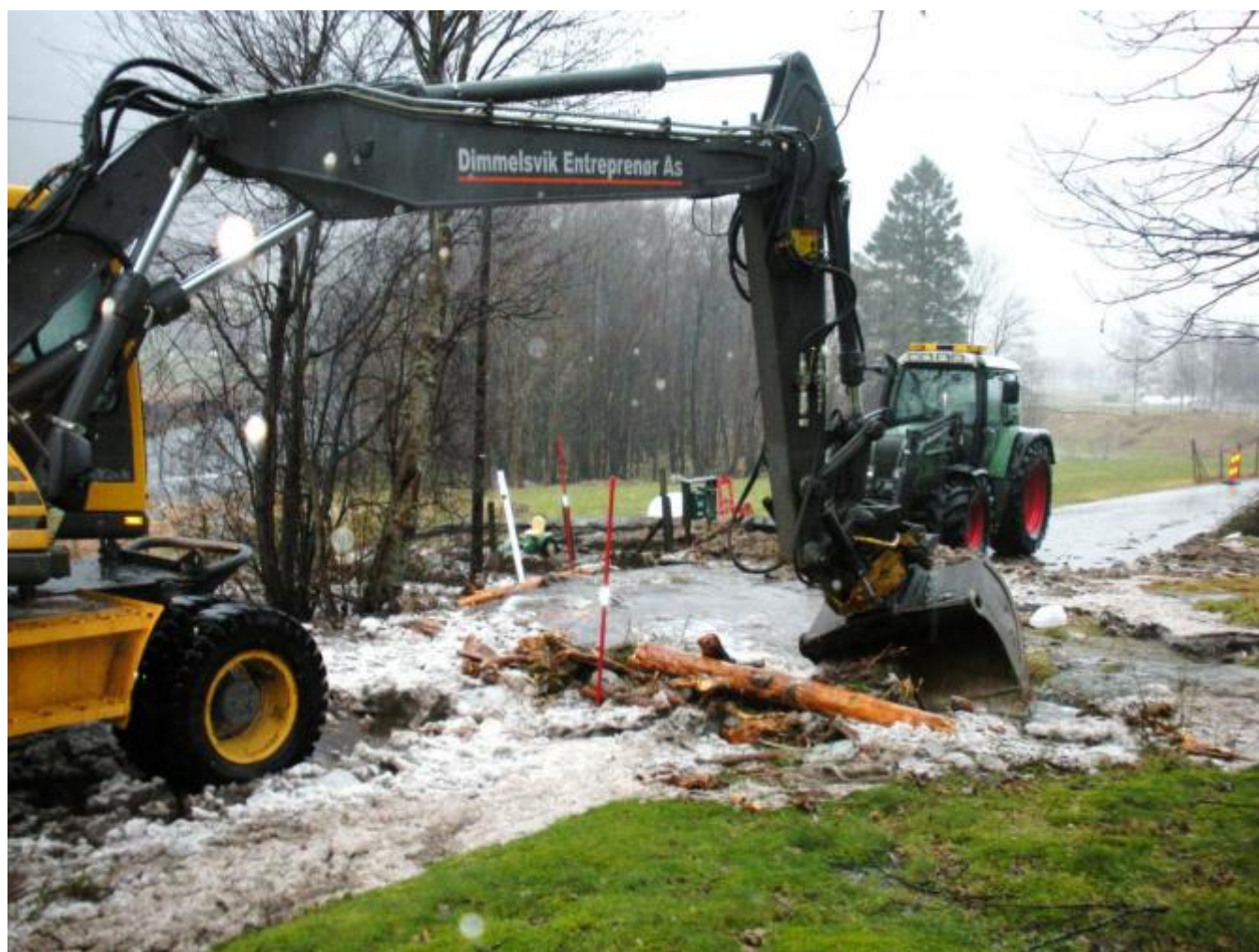
Dimmelsvik Entreprenør laga veg i vellinga
