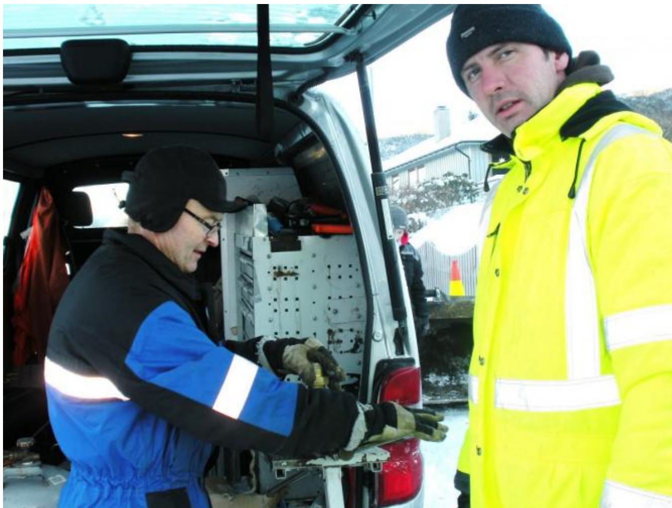
Rørleggjarane Johannes Feet og Knut Stensletten i arbeid i Skorane.
