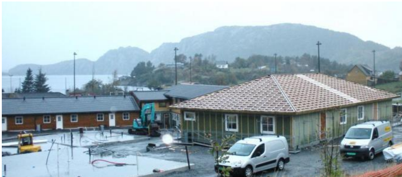
Arbeidet med den første tomannsbustaden har kome langt.
