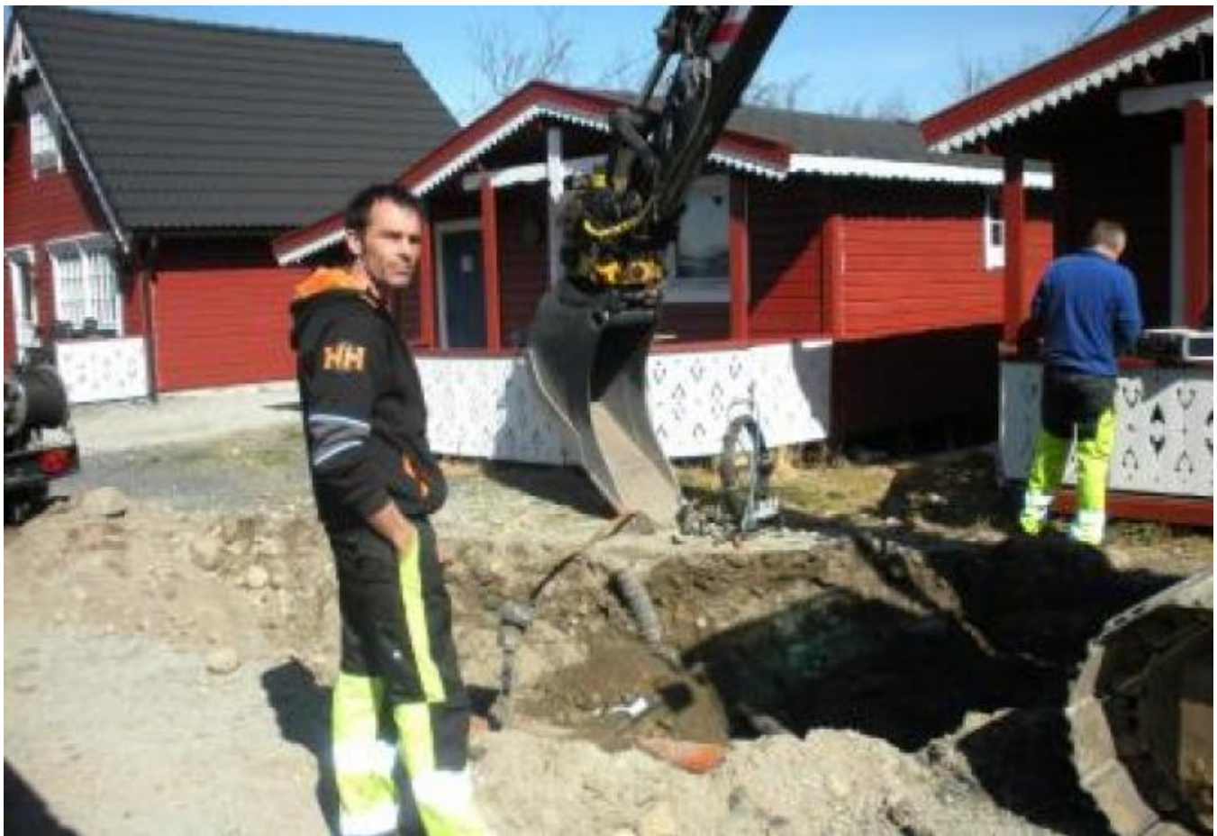
Arbeidet med kloakkanlegget starta i april på Rabben. (Foto: Ola Matti Mathisen)
