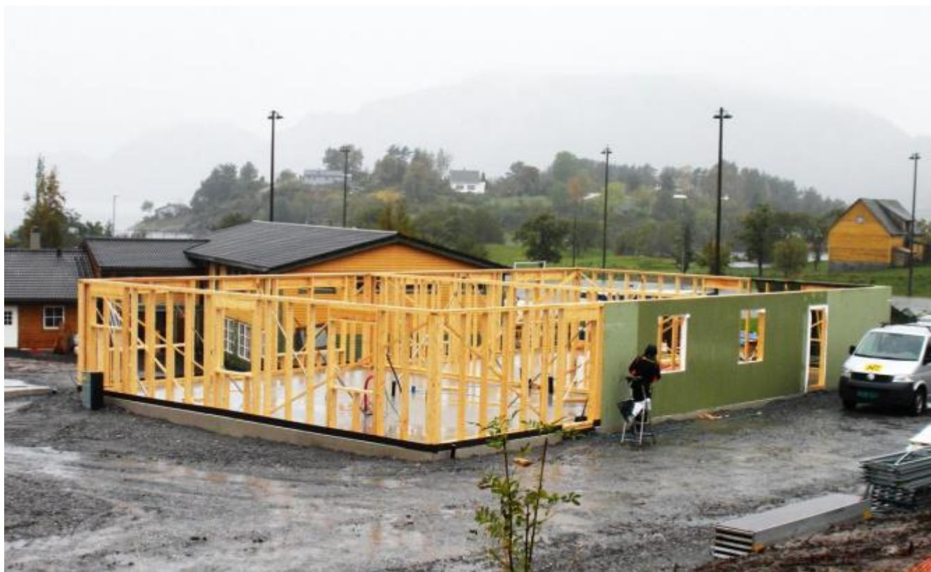
Den første av dei 3 tomannsbustadane er under byggjing no. (Foto: Ola Matti Mathisen)
