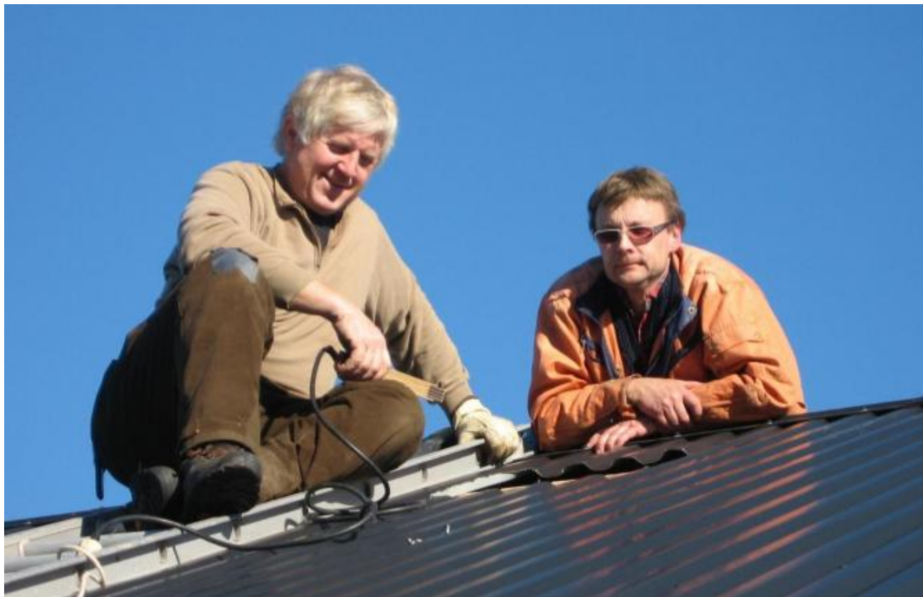
Svein Ottar Rørheim og Hans Reidar Kjærland på taket der dei får pipa på plass (Foto: Kristian Olav Bringedal)
