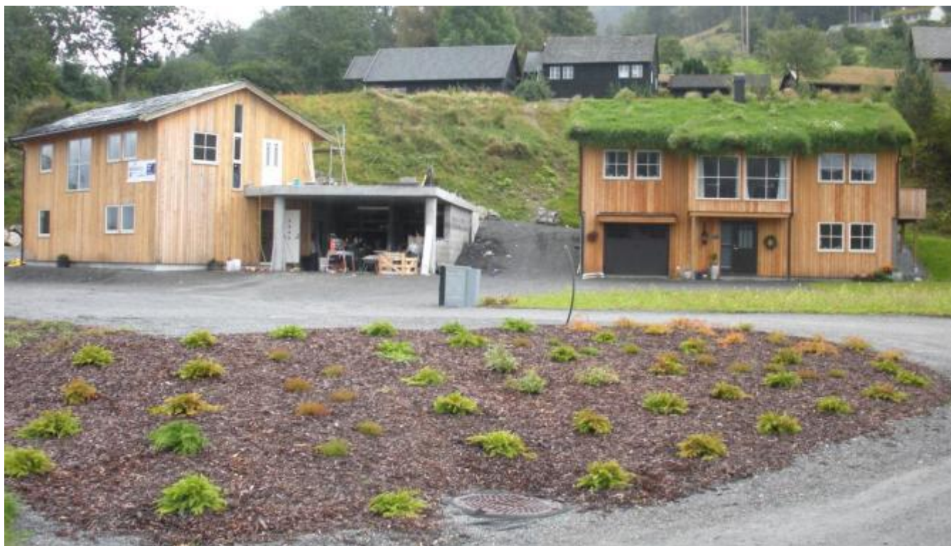
Dei to første husa i prosjektet på Ytre Eik. Hus nummer to er innflyttingsklart no. (Foto: Ola Matti Mathisen)
