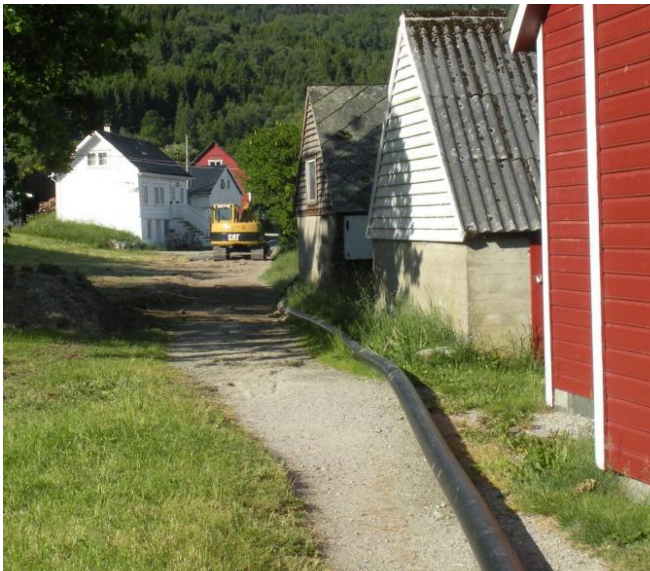
Arbeidet langs stranda går raskt unna. (Foto: Ola Matti Mathisen)
