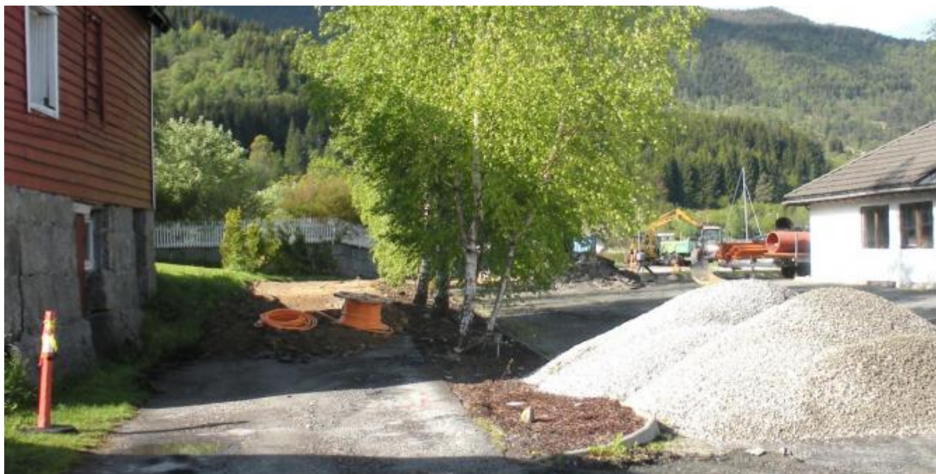
Leggjinga av ny kloakkleidning har i føremiddag nådd fram til Vertshuset. (Foto: Ola Matti Mathisen)
