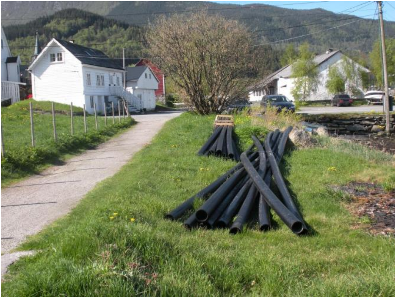
Røra ligg klare og blir snart gravd ned vidare langs stranda.
