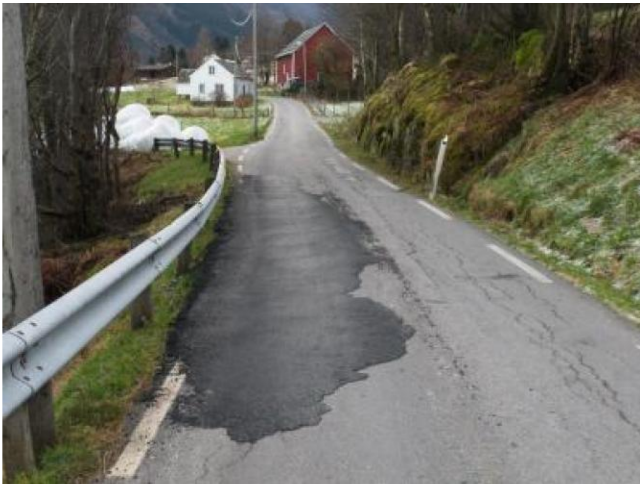
Ein asfaltklatt ved Djupehølen er den einaste reparasjon som er skjedd på Døsslandsio førebels
