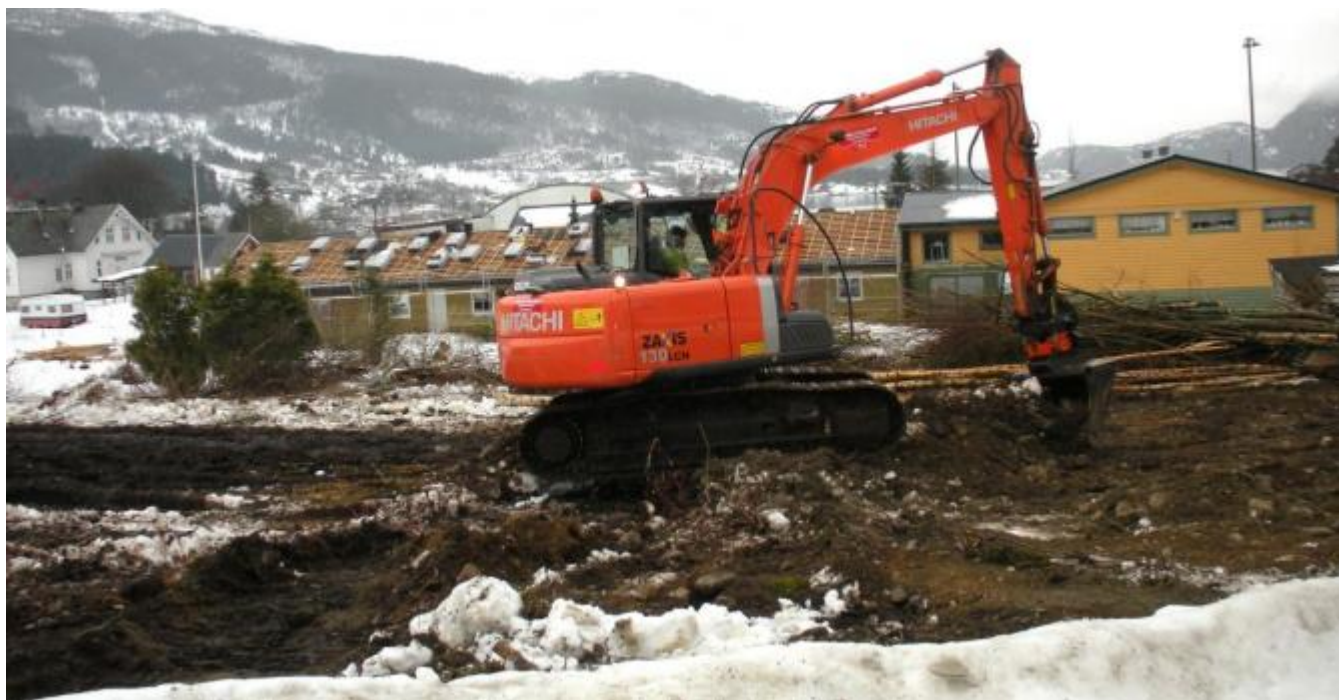
Grunnarbeidet for tomannsbustadane er no igang. (Foto: Ola Matti Mathisen)
