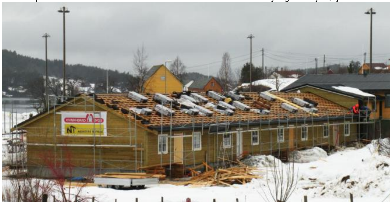
Arbeidet med bustadane på den gamle muren har gått raskt unna. (Foto: Ola Matti Mathisen)
