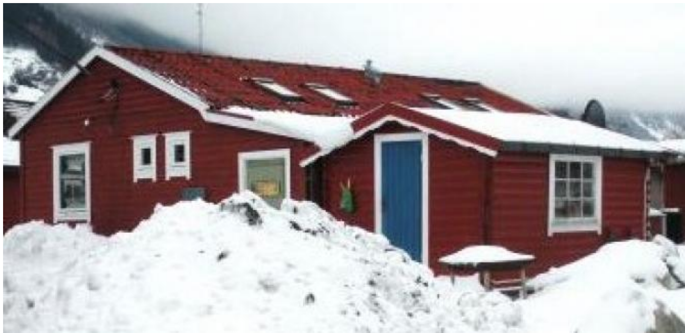
Det er truleg likevel langt fram for opprusting av sanitæranlegget på Rabben. (Foto: Ola Matti Mathisen)
