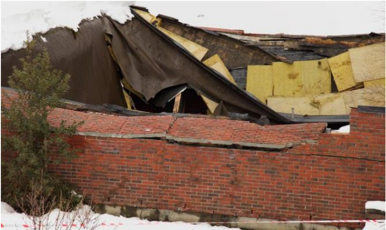
Hatlestrand-taket som kollapsa. (Foto: Kvinnheringen)
