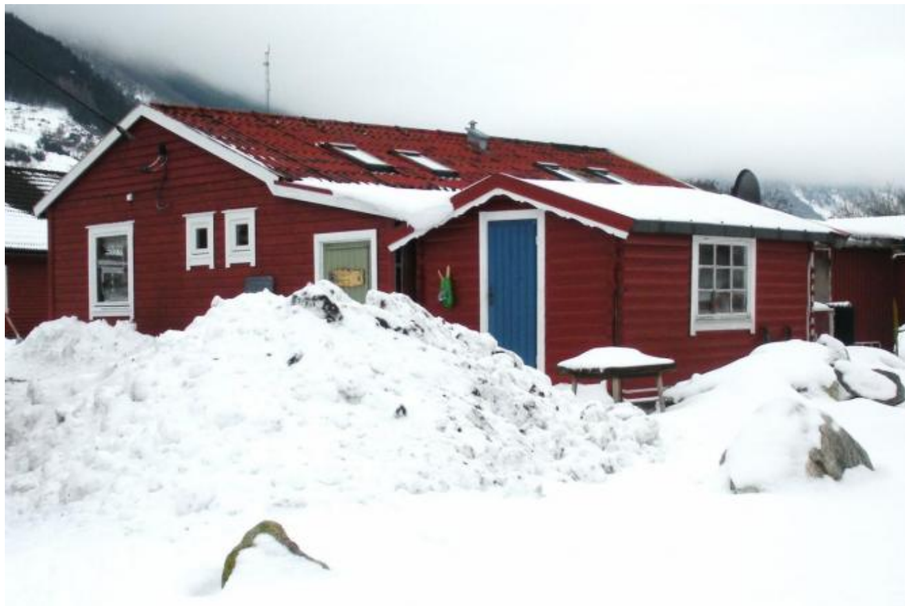
Oppgradering av sanitæranlegget er eit viktig prosjekt på Rabben. (Foto: Ola Matti Mathisen)
