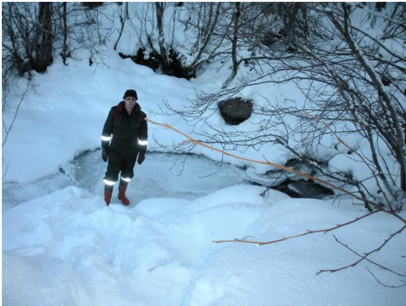
Leiar av vassverket Hans Reidar Kjærland ved hovudinntaket. (Foto: Ola Matti Mathisen)
