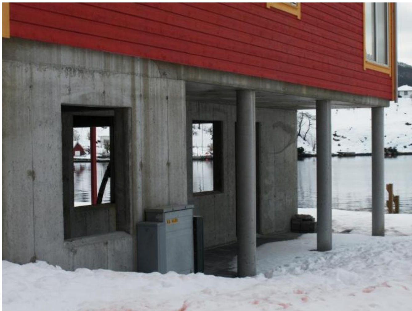
Dette er underetasjen som det no er knytta pålegg til. (Foto: Ola Matti Mathisen)
