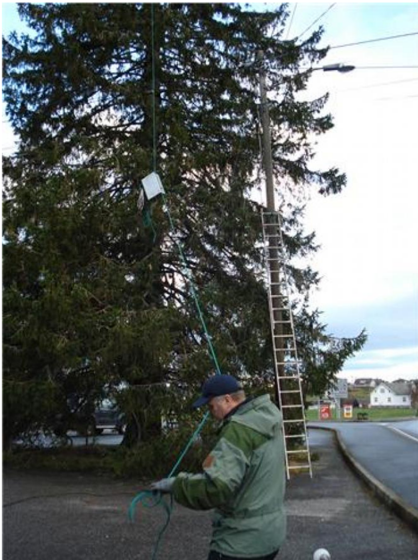
Før ein kan få lyslekkjene på plass må koplingskassen heisast opp
