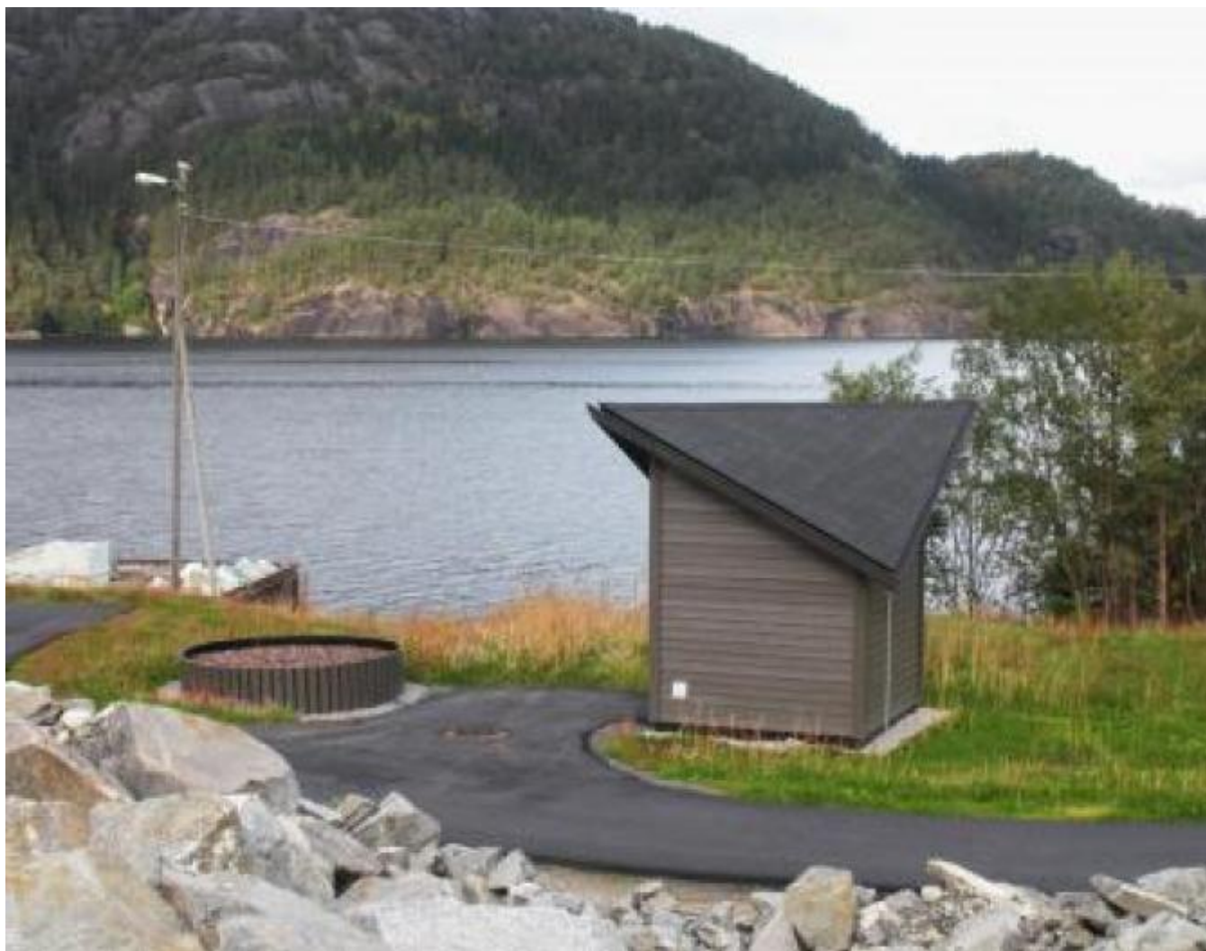
Like over nyttår startar neste byggjesteget i kloakksaneringa. Hit til Børnes skal kloakken frå dei sentrale delane av bygda pumpast. (Foto:Ola Matti Mathisen)
