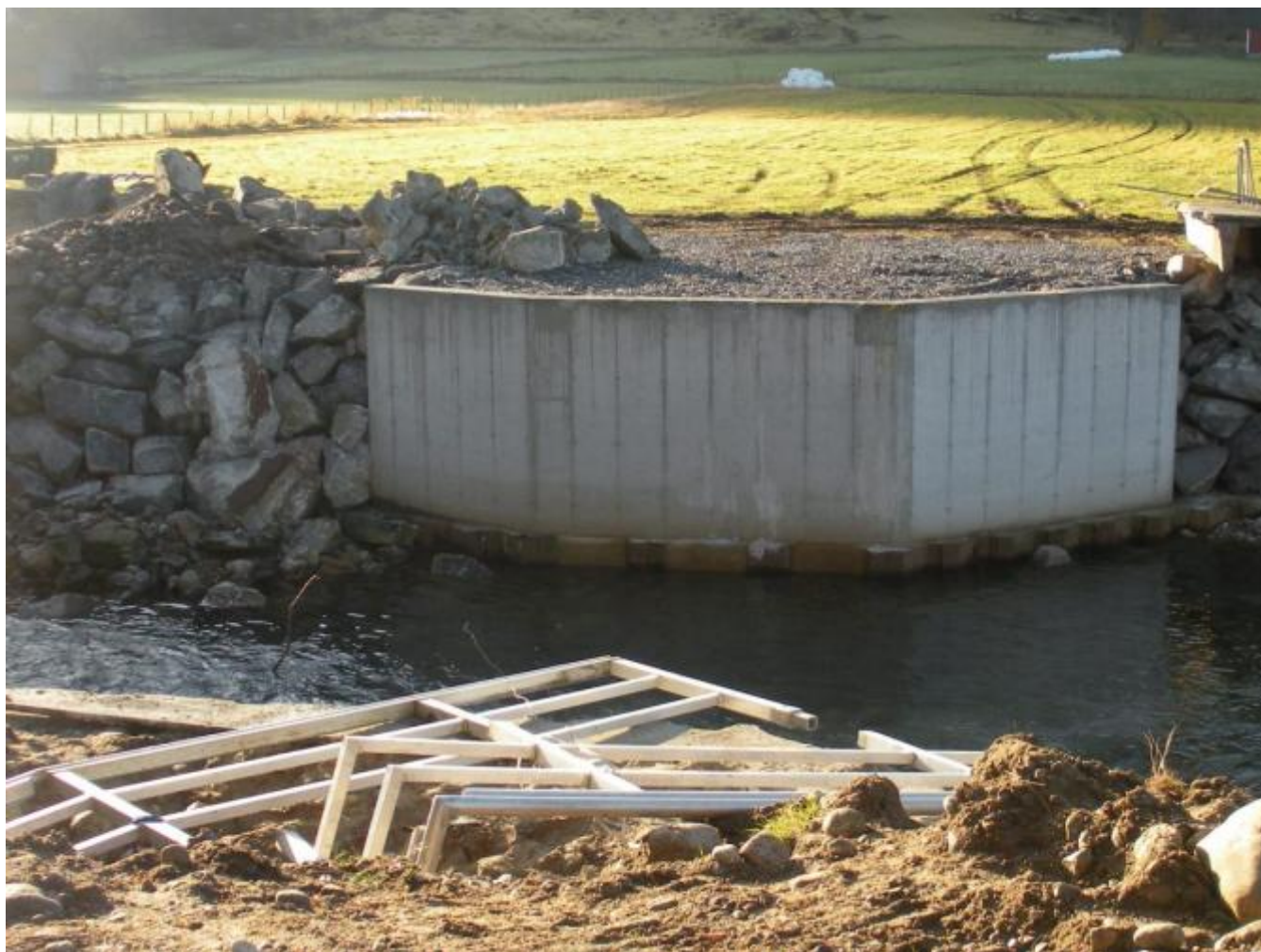
Kva slags bru blir det her til slutt? Den havarerte brua ligg på andre sida. (Foto: Ola Matti Mathisen)
