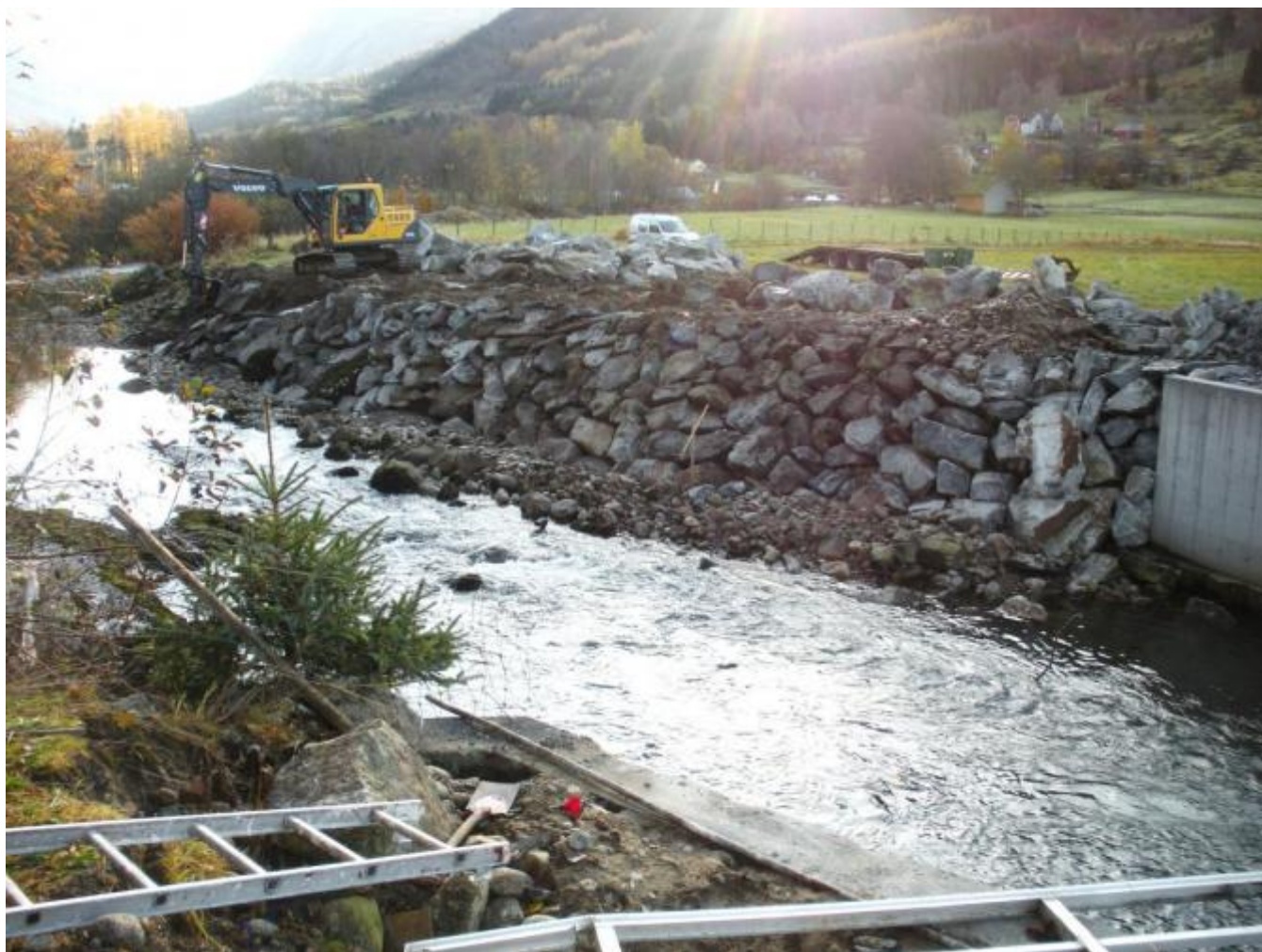
Det blir fin plastring også ovanfor brua. (Foto: Ola Matti Mathisen)
