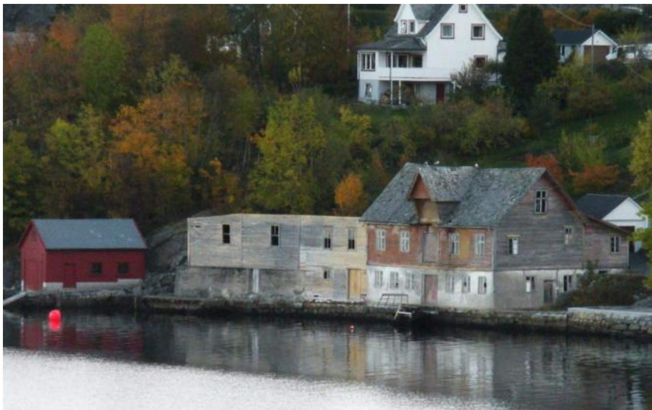
Bygningen som no blir fjerna har i mange år dominert strandlinja i Beinavikjo. (Foto: Ola Matti Mathisen)
