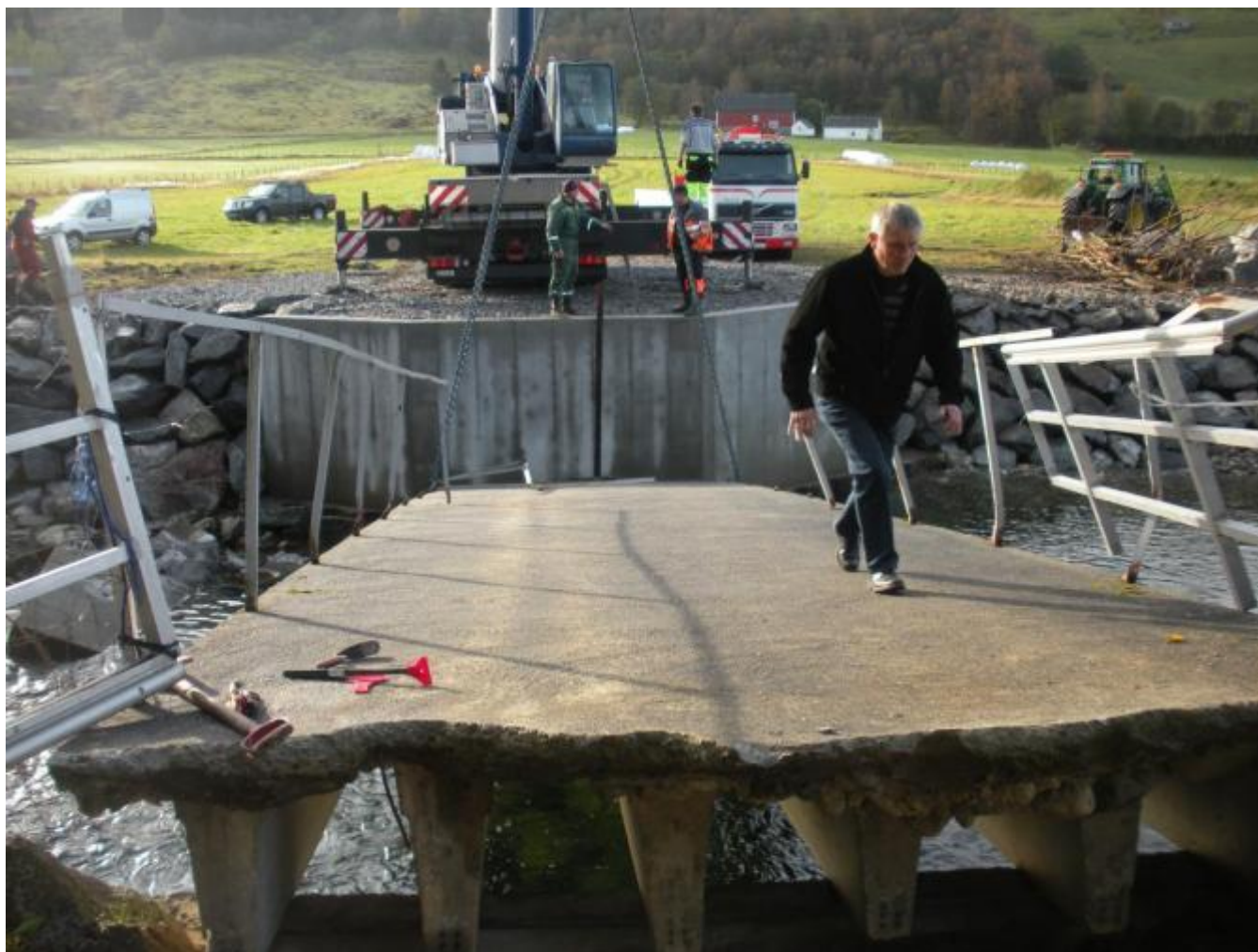
Alt klart til å lyfta opp brudekket. Grunneigar Magne Huglen kjem opp brua. (Foto: Ola Matti Mathisen)
