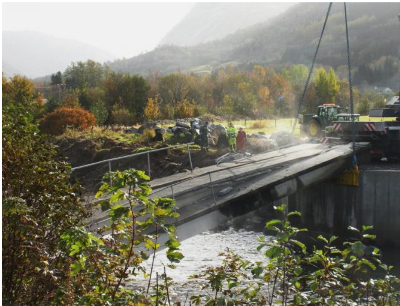
Brua fell ned på andre sida. (Foto: Ola Matti Mathisen)
