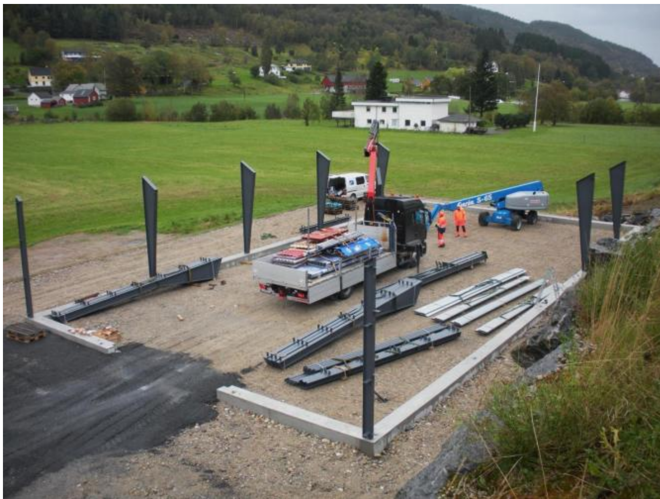
Monteringa av stålkonstruksjonane starta umiddelbart tysdag. (Foto: Ola Matti Mathisen)
