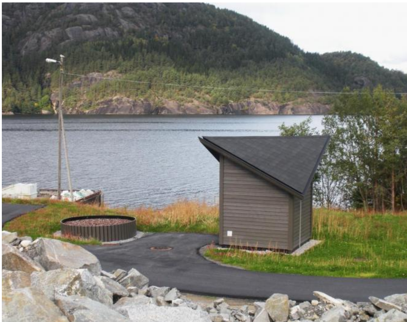
Kloakkreinseanlegget på Børnes er klart for tilkopling av kloakkledningane via fjorden. (Foto: Ola Matti Mathisen)
