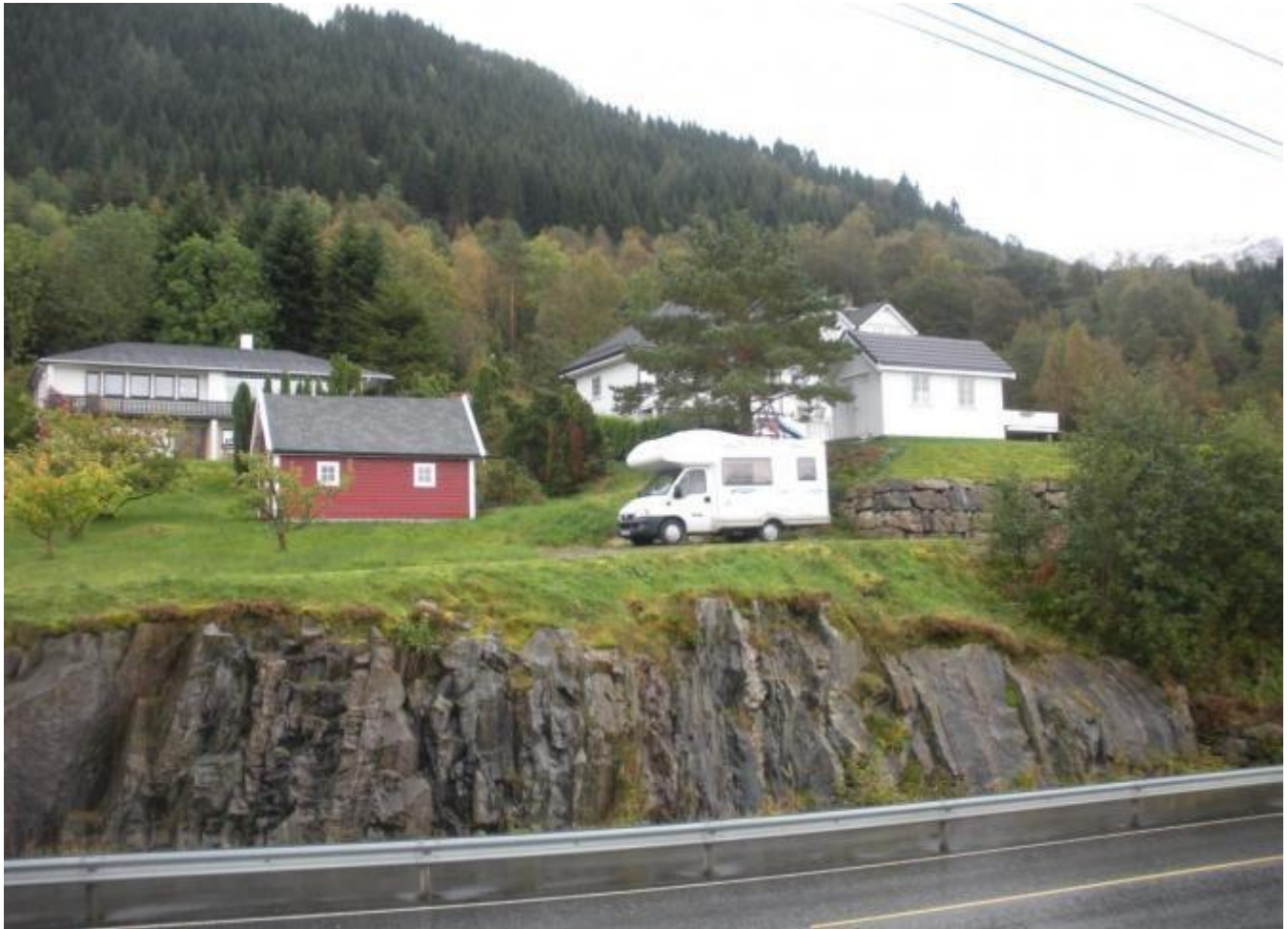
Det nye huset i Ospelunden skal liggja ovanfor huset til høgre. I forgrunnen riksvegen. (Foto: Ola Matti Mathisen).
