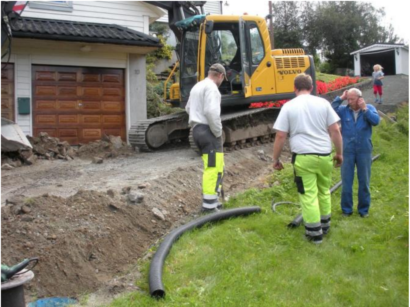
Haugland Maskin i gang med grundige førebuingar for asfaltleggjinga. Lengst til høgre ein fornøgd oppsittar - Alf Eidsvik. (Foto: Ola Matti Mathisen)
