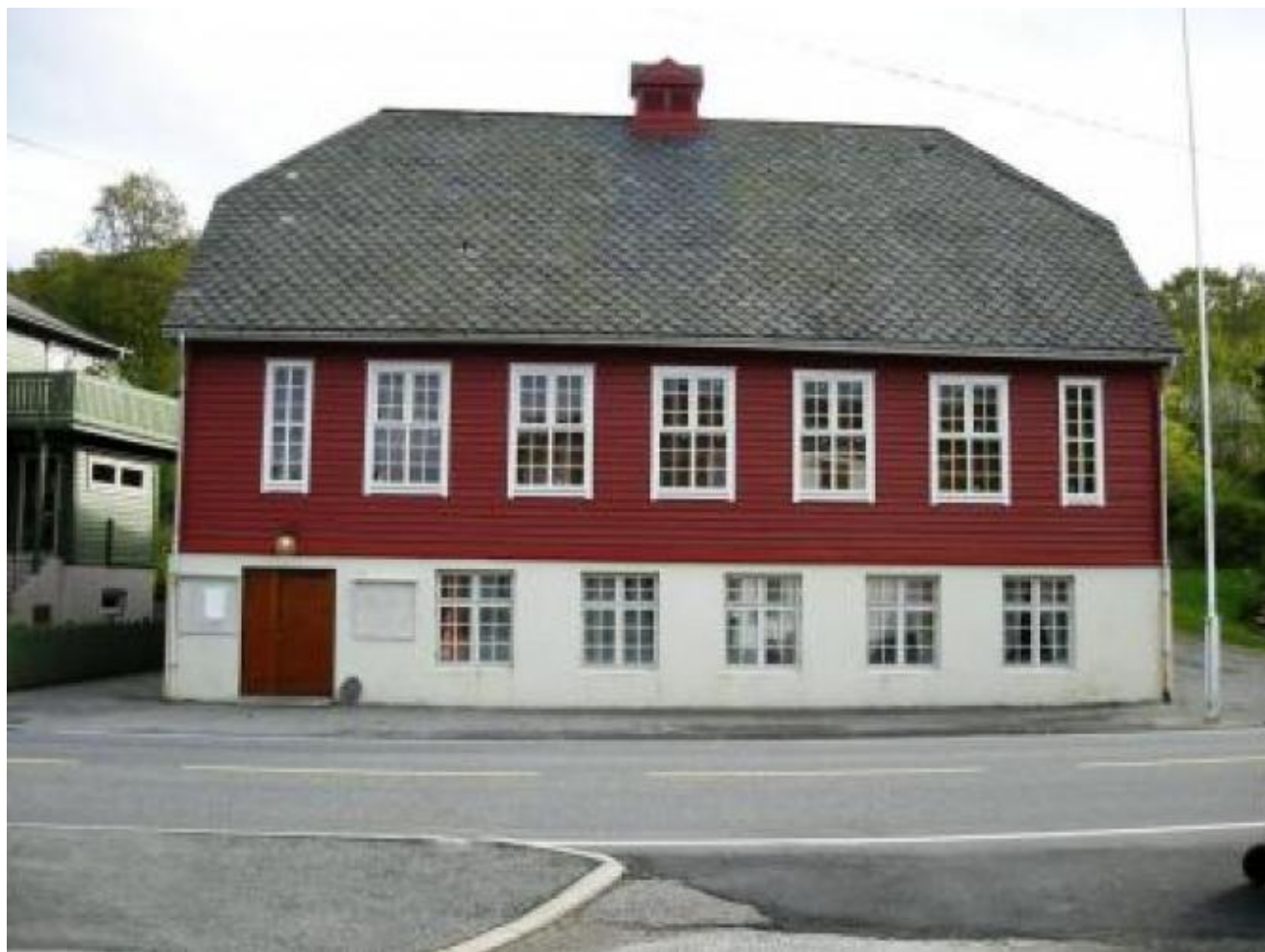
Det er gjort mykje bra branntryggleiksarbeid i Helgheim. (Foto: Ola Matti Mathisen)
