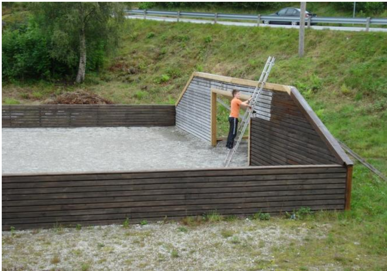
Tre ungdommar har gjort ein flott jobb med rydjingsarbeid og beising. (Foto: Thor Inge Døssland)
