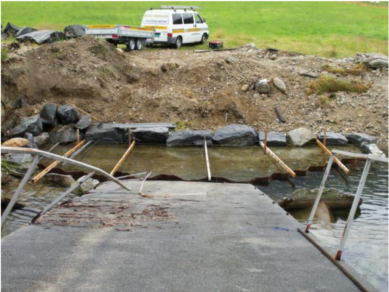
Førebuingane til fundament-støyping er i gang. (Foto: Ola Matti Mathisen)
