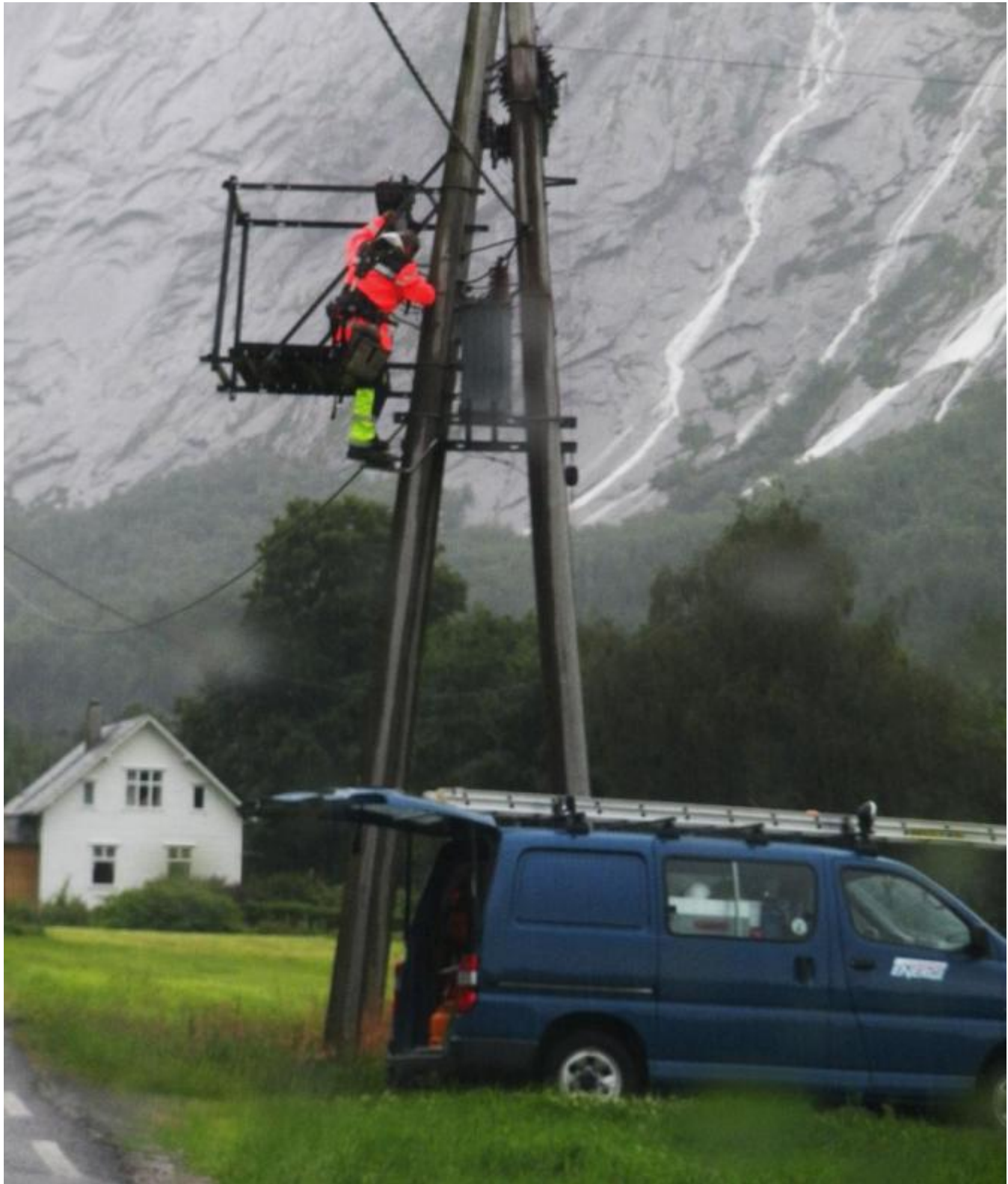
Ein transformator vart slegen ut av toreveret. (Foto: Ola Matti Mathisen)
