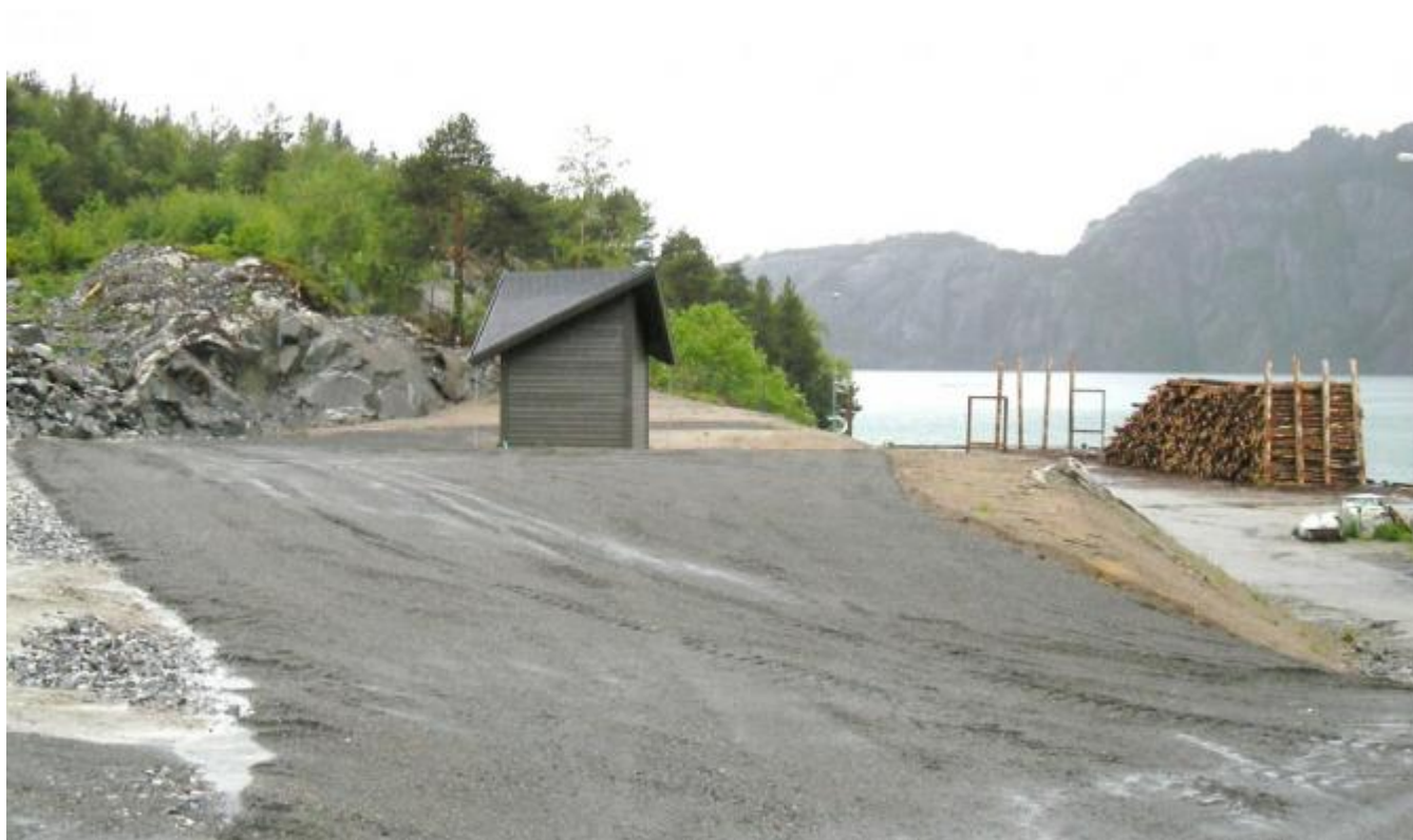
Det har vorte fint rundt kloakkreinseanlegga. Her er det på Børnes dit leidningane frå dei sentrale delane av Uskedalen skal førast. Servicebygningane på Børnes og Korsnes kallast populært for katedralane. (Foto: Ola Matti Mathisen)
