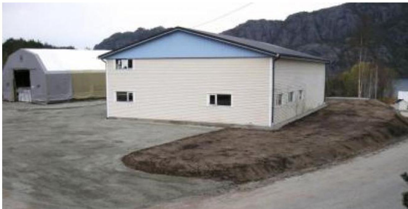
Fint pynta på Børnes - på tomta til det innflytta firma Kvinnherad Byggutvikling & Industriservice. (Foto: Ola Matti Mathisen)
