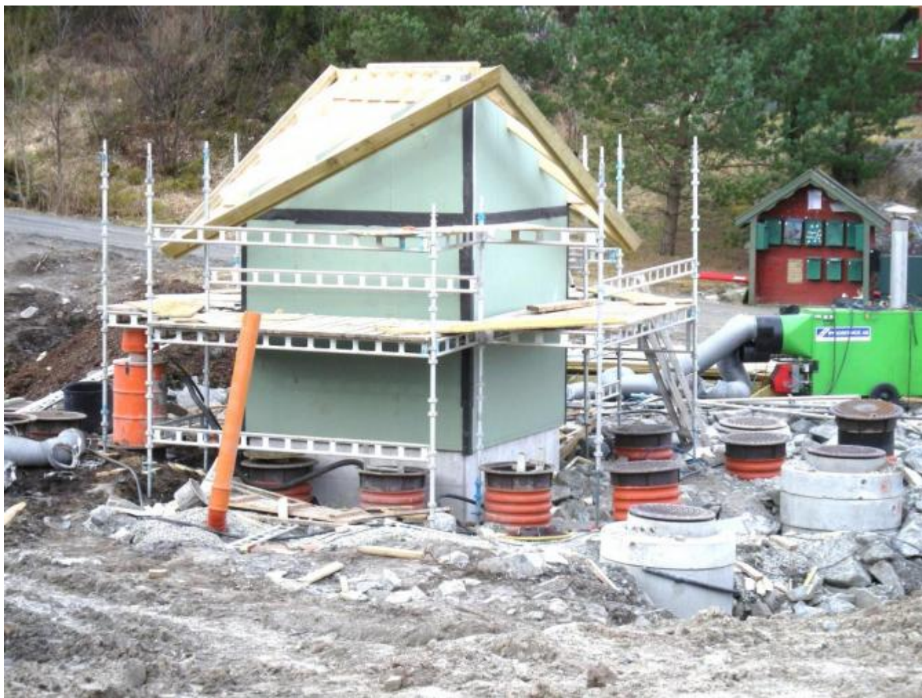
Servicebygget på Korsnes tar form. (Foto: Ola Matti Mathisen)
