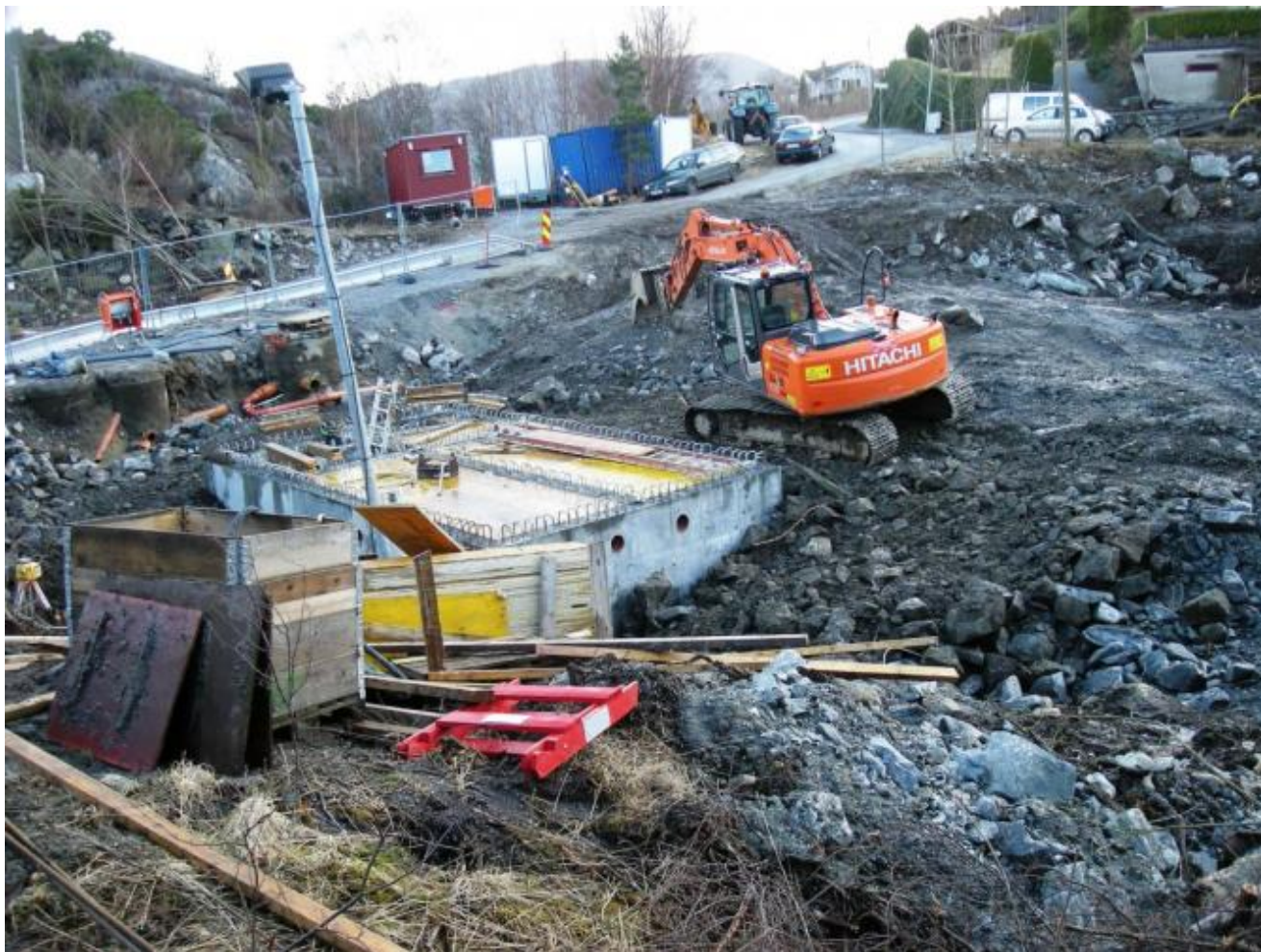
Så langt har arbeidet med Korsnes-anlegget kome. (Foto: Ola Matti Mathisen)
