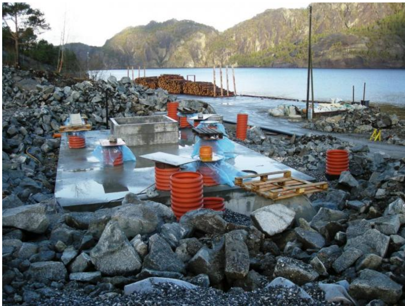
Så langt har arbeidet med Børnes-anlegget kome. (Foto: Ola Matti Mathisen)
