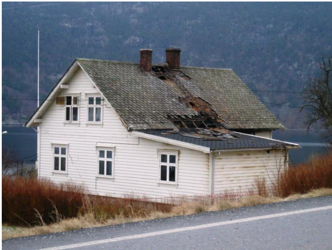
Huset på Ljosnes er totalskada, opplyser eigaren. (Foto: Ola Matti Mathisen)
