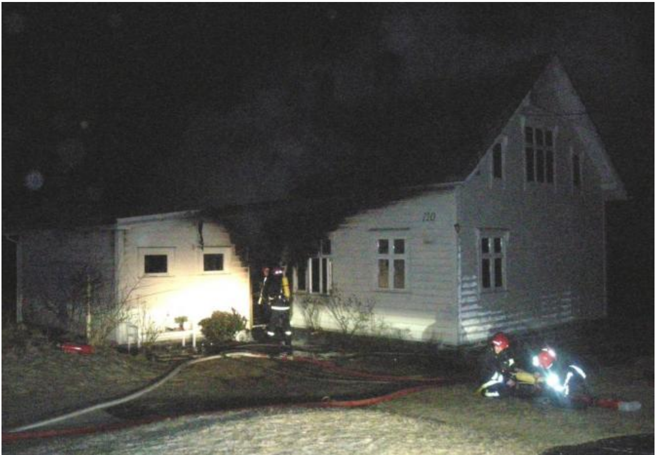
Ljosnes-huset vart påført store skadar. (Foto: Ola Matti Mathisen)
