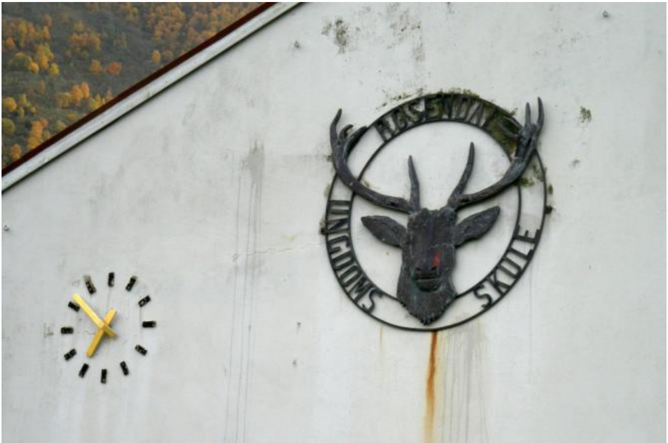
Når blir arbeidet ved ungdomsskulen i rosendal ferdigstilt, undrar mange. (Foto: Ola Matti Mathisen)
