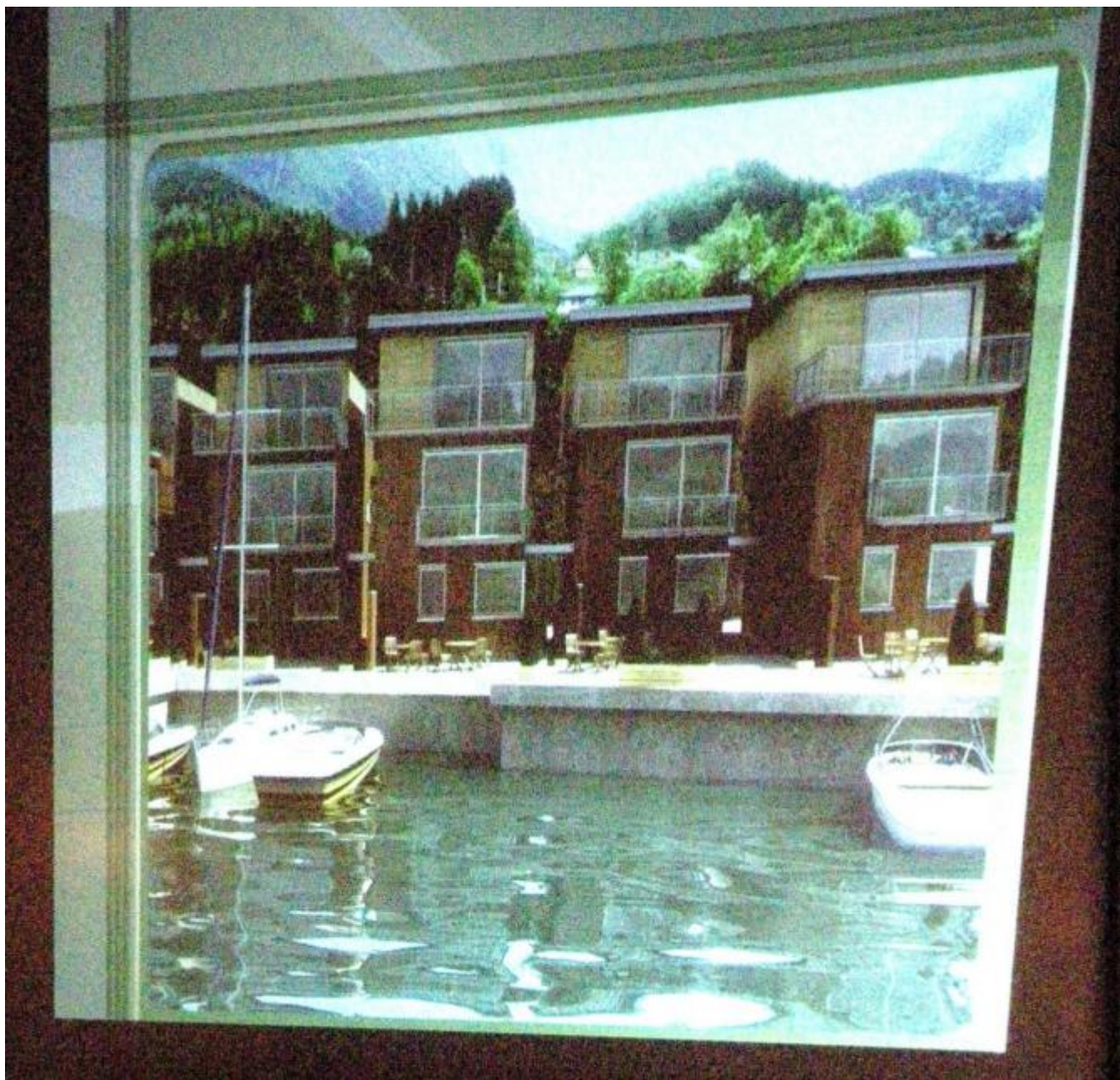
Eikelandet-prosjektet sett frå framsida
