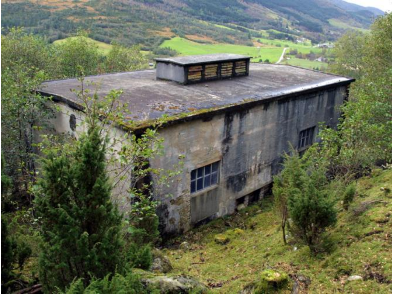
Det gamle kraftverket i Tverrelva som til slutt havarerte. Her låg inntaketet på kote 360, no vil detkome til å liggja på 530 eller 565. (Foto:Anbjørn Høivik)
