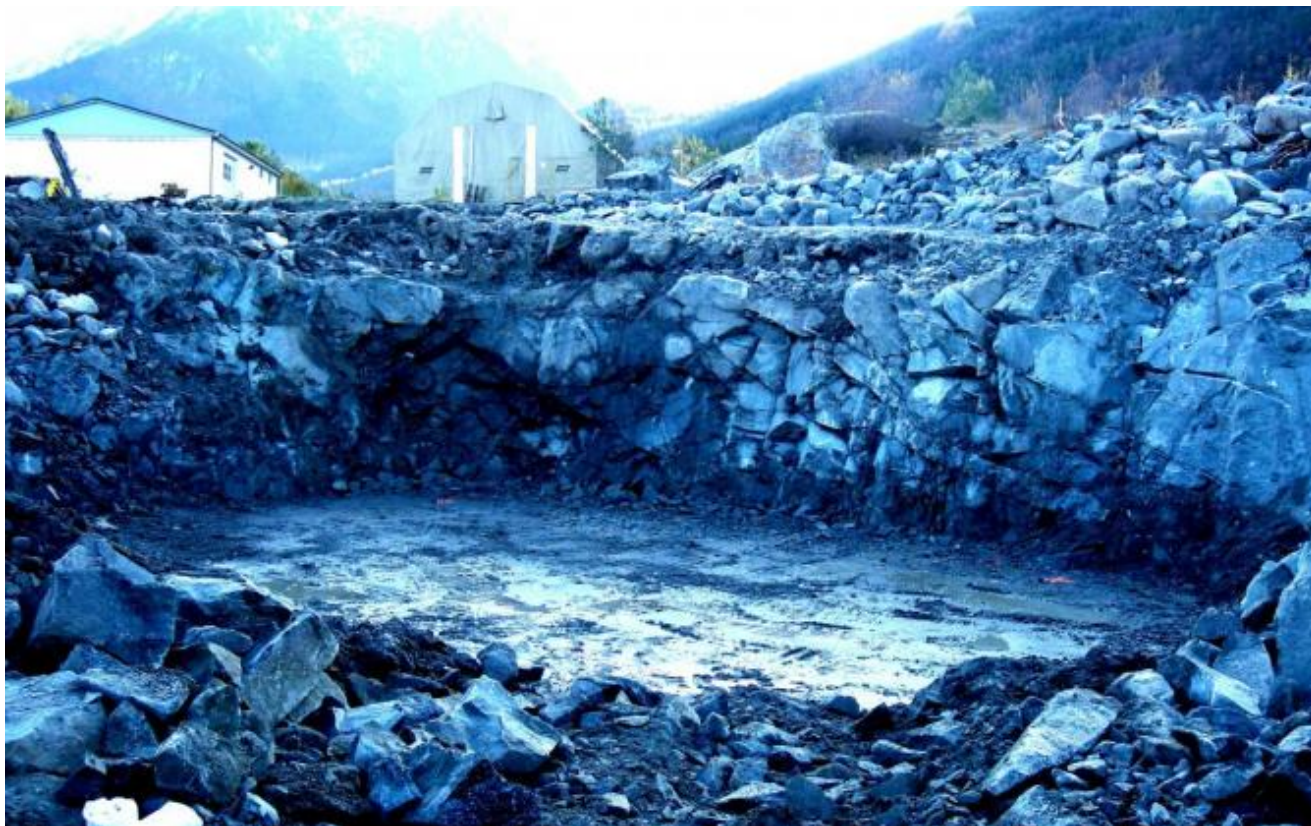
Sverre Myklebust har gjort unna første etappe på Børnes og no kan Byggservice rykka inn. (Foto: Ola Matti Mathisen)
