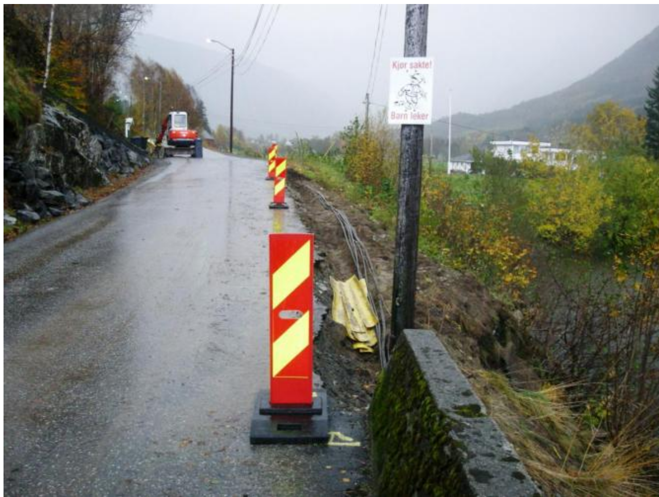
Sikring av den trafikkfarlige biten ovanfor brua er no i gang. Snart kjem det eit stålrekkverk oppover her. (Foto: Ola Matti Mathisen) . .
